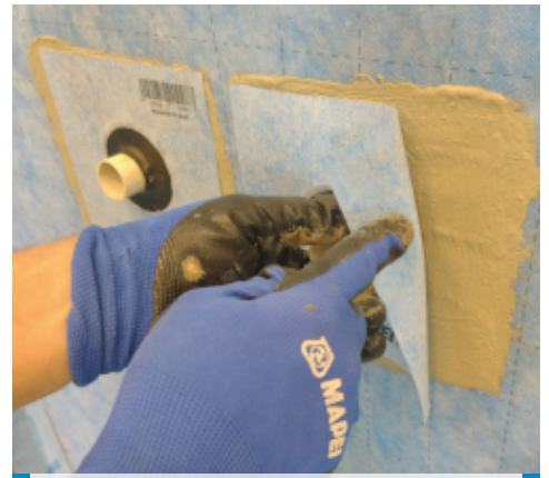
Mapeguard PC elhelyezése
