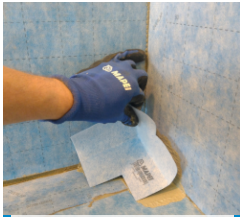
Mapeguard IC elhelyezése
